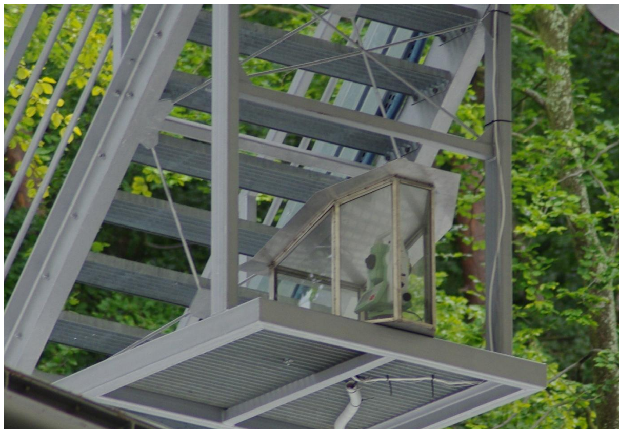
Rys. 3.6. Stanowisko tachimetru (źródło: własne)
