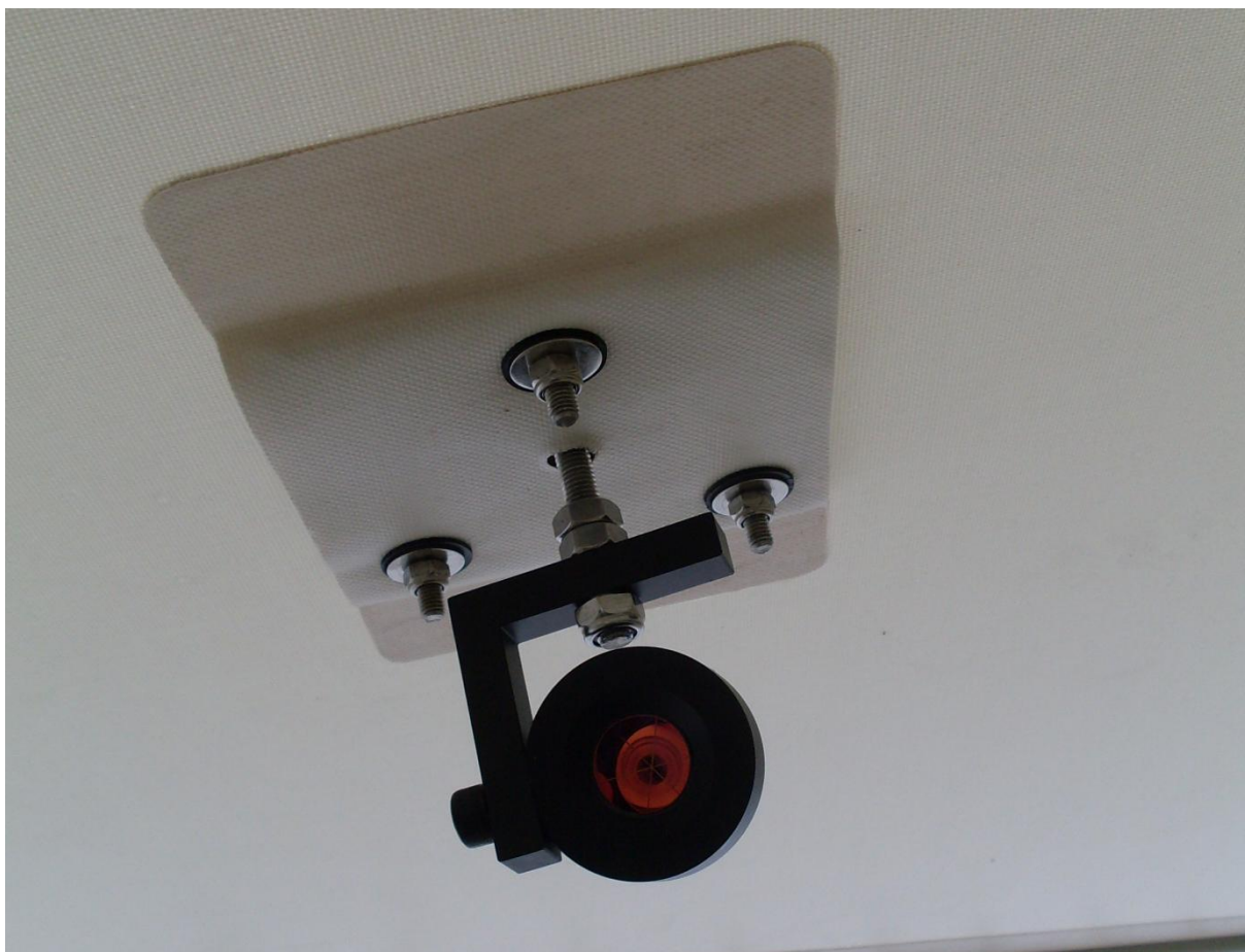
Rys. 3.8. Punkt kontrolowany zlokalizowany na membranie zadaszzenia Operry Leśnej (źródło: własne)
