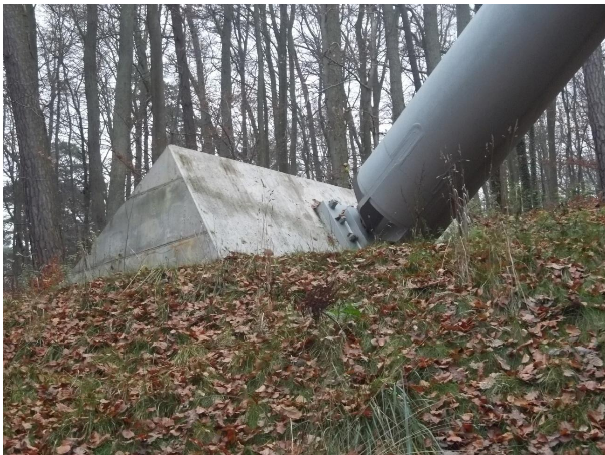
Rys. 3.2. Przytwierdzenie łuku nośnego do bloku fundamentowego (źródło: własne)
