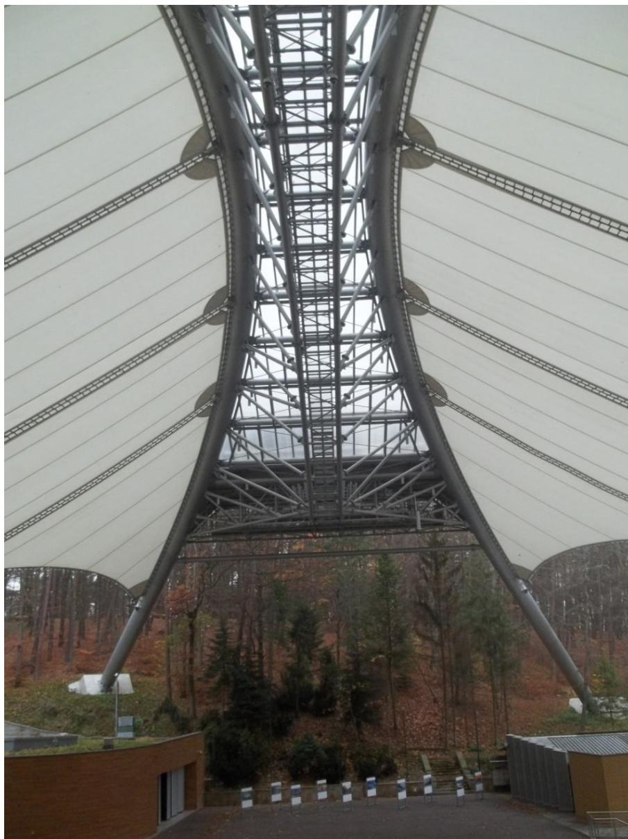
Rys. 3.3. Łuki nośne konstrukcji zadaszania Opery Leśnej w Sopocie (źródło: własne)
