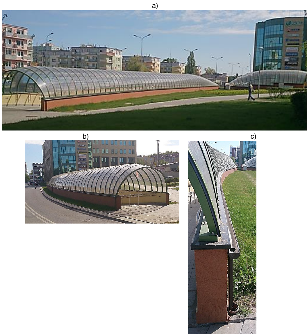
Rys. 10.1 Przejście podziemne pod drogą komunikacyjną (tunel): wyjścia z tunelu a) widok, b) zbliżenie, c) szczegół oparcia przekrycia na ścianach obudowy wyjść z tunelu
