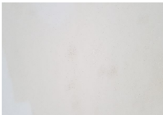
Rys. 11.1.3 Usterki tynków w poziomie stropu nad I piętrzem – widok sufitu po wykonaniu miejscowego szpachlowania zawilgoconych miejsc tynku
