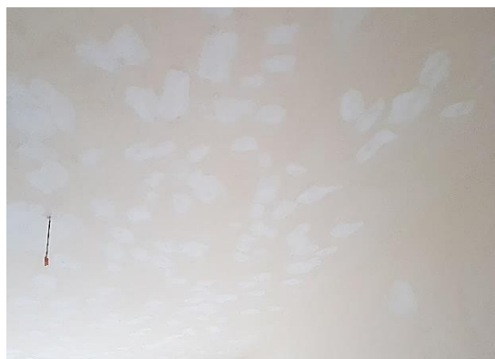
Rys. 11.1.3 Usterki tynków w poziomie stropu nad I piętrzem – widok sufitu po wykonaniu miejscowego szpachlowania zawilgoconych miejsc tynku
