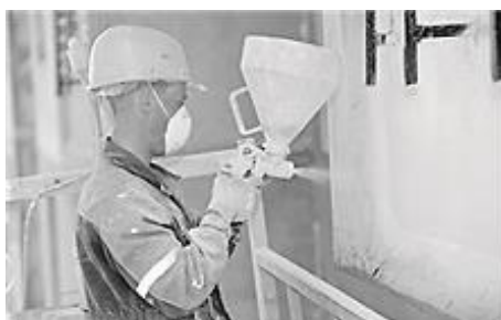
Rys. 6.2.6 Narzucanie wyprawy tynkarskiej za pomocą pistoletu natryskowego
