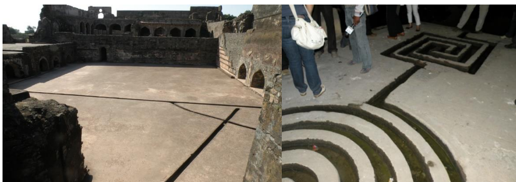
Rys. 54 Przykład szczelin odprowadzających wodę (po lewej) oraz labirynty w utwardzonej powierzchni (po prawej) (fot. M. Gajewska)
