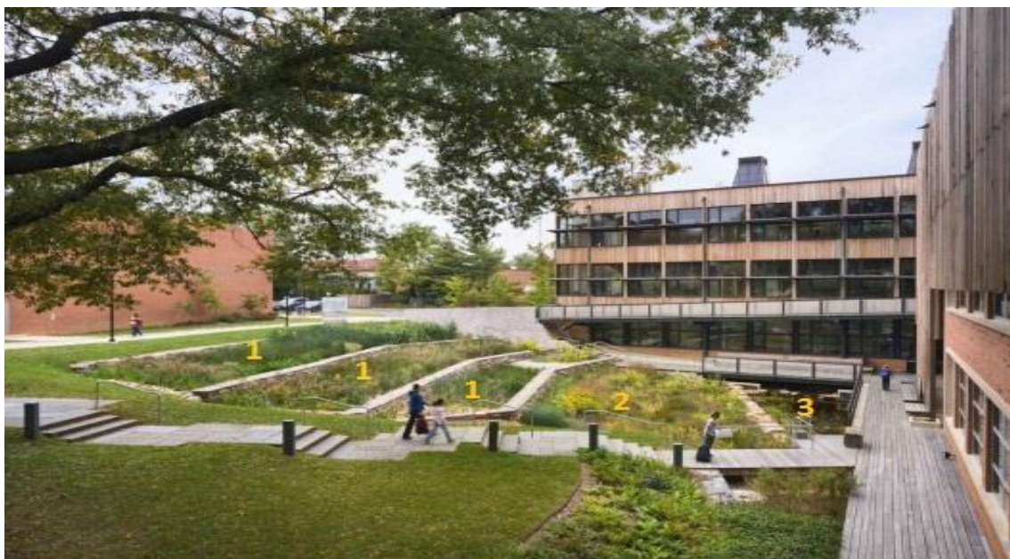
Rys. 31 System oczyszczania ścieków szarych oraz wody opadowej na dziedzińcu prywatnej szkoły Sidwell Friends w Waszyngtonie (1 – trystopniowy system ziół hydrofitowych do oczyszczania ścieków szarych, 2 – ogród deszczowy, 3 – staw retencyjny); Źródło: http://www.archdaily.com/32490/ad-interviews-kieran-timberlake
