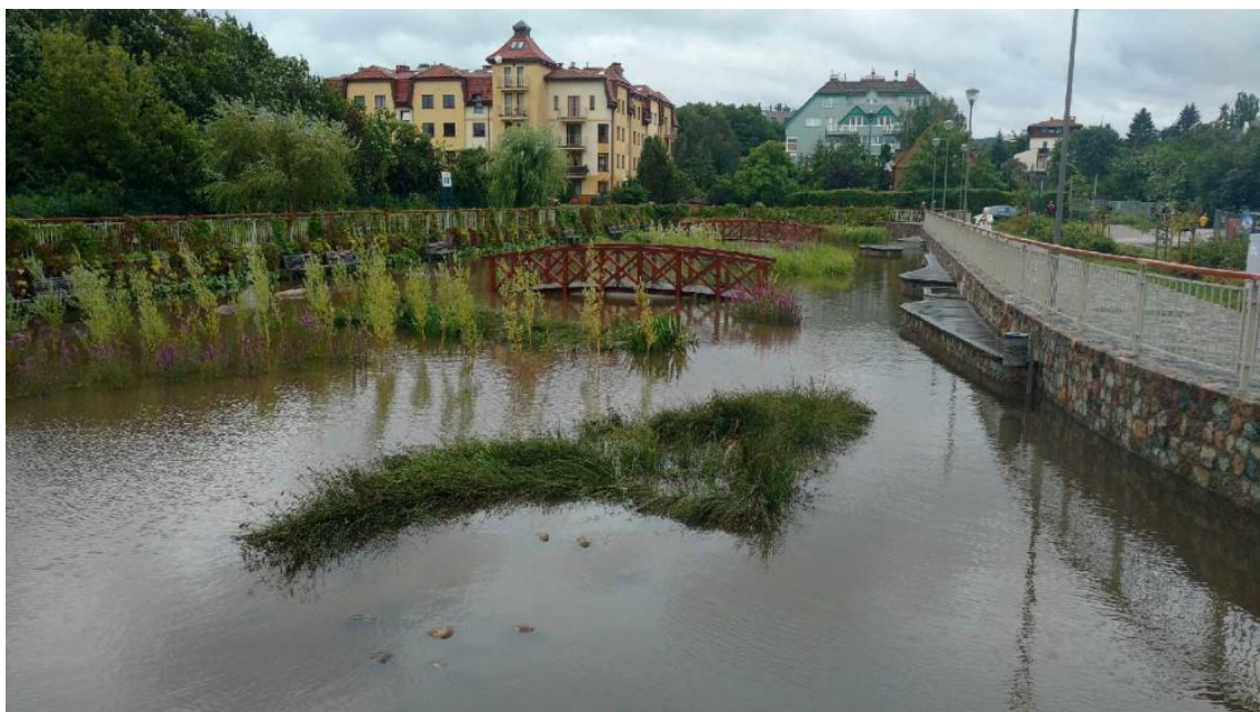
Rys. 42 Niecka zbiornika wypełniona wodą po rekordowym opadzie w dn. 15 lipca 2016 r. Fot. E.Wojciechowska
