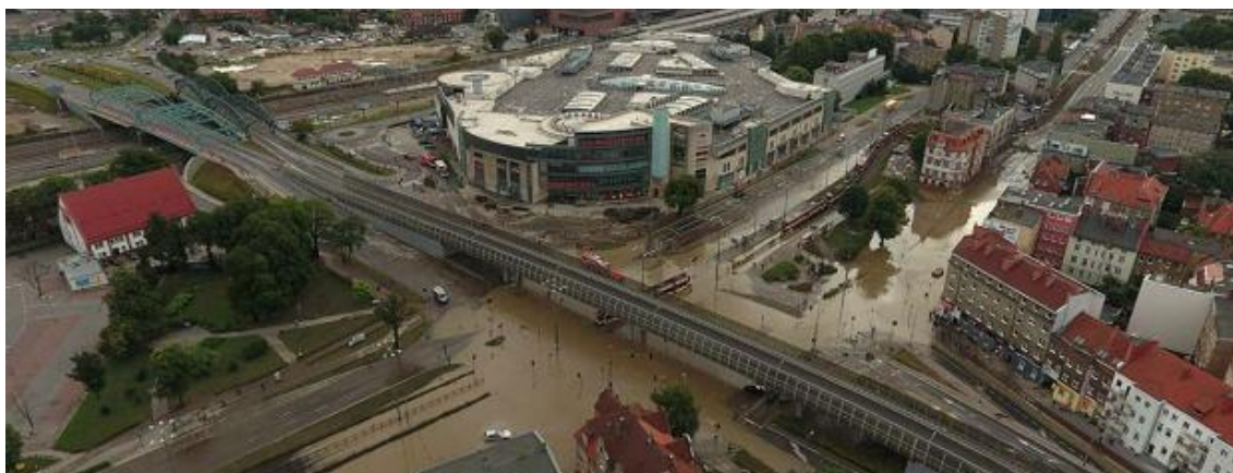
Rys. 8 Zalane skrzyżowanie Al. Grunwaldzkiej i ul. Słowackiego w Gdańsku, 15 lipca 2016 r.; źródło: http://trojmiasto.wyborcza.pl/trojmiasto/5,127406,20402671.html ; fot. Dominik Werner.
